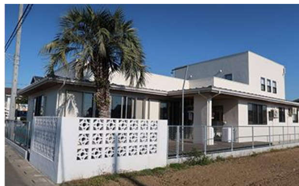
(写真：ラフキッズ保育園様の外観)
